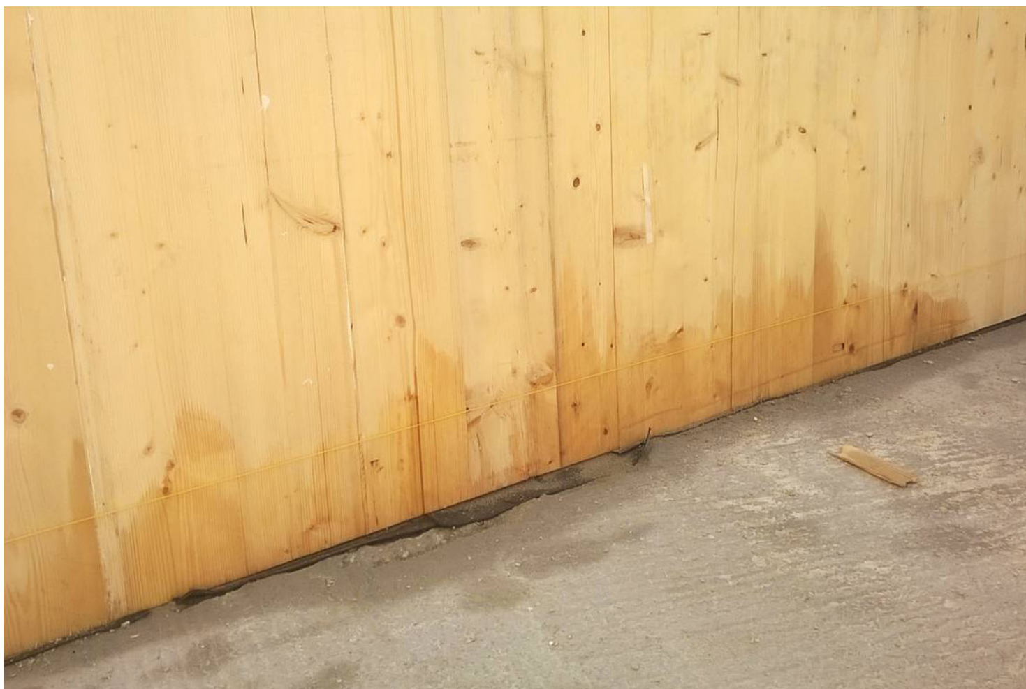
La parete in legno ha assorbito l'acqua nonostante la presenza della guaina anti-risalita.
